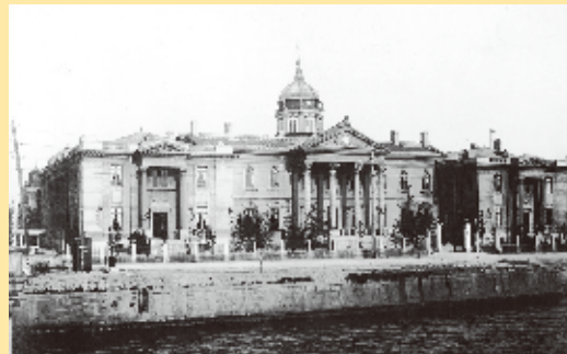
「江之子島政府」と呼ばれた立派な大阪府庁舎。
