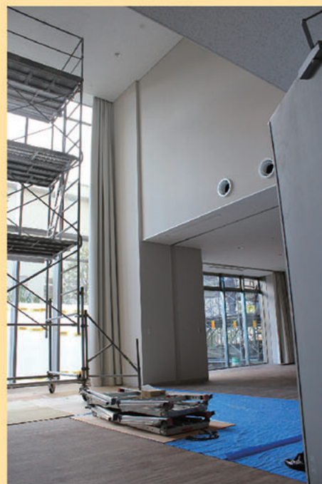
工事中のフラッグスタジオ。面積だけでなく天井も高くつくられています
