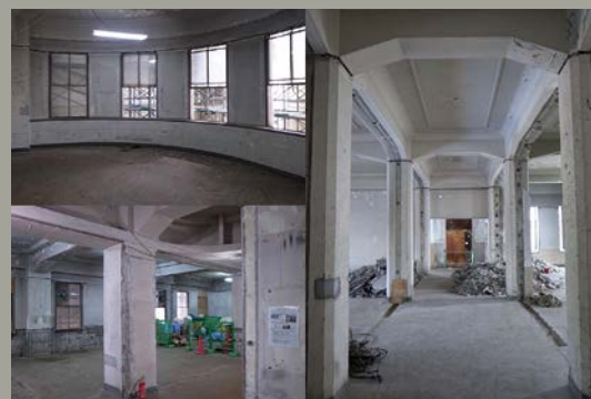
改修前の建物内部
