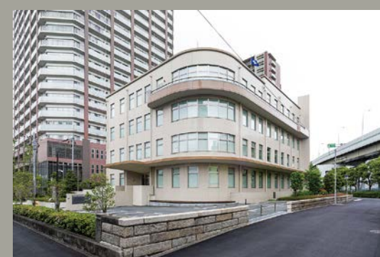
大阪府立江之子島文化芸術創造センターへと生まれ変わった工業会館
