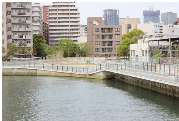
整備後の遊歩空間。2017年3月末には広場部分の工事も完了し、全体の供用が始まる予定
