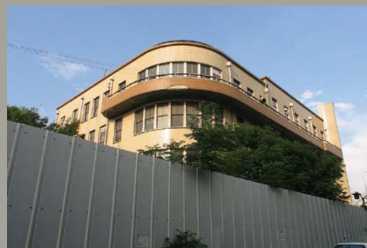
改修前の工業会館
